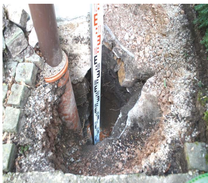
Zd.nr1.Odkrywka nr1. Badanie prawidłowości poziomu posadowienia budynku, poprzez wykonanie odkrywki do głębokości 120 cm poniżej poziomu terenu. Ściana fundamentowa wykonana z nieociosanego kamienia wapiennego z nielicznymi oznakami spoiwa glinianego i wapiennego. Widoczna rura spustowa oraz przyłącz odwadniający wody deszczowe z połaci dachowej do kanalizacji miejskiej nie zostały one naniesione na państwową mapę sytuacyjno-wysokościową.
