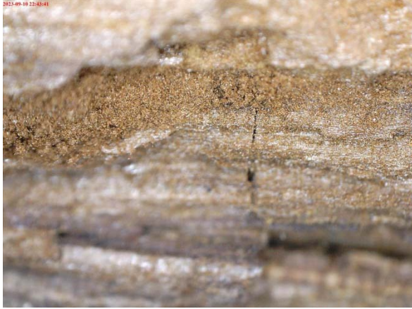
Zd.nr 15.Badanie mikroskopowe pobranej próbki drewna .Zniszczenie drewna bielastego , brunatny rozkład drewna w partiach obwodowych.
