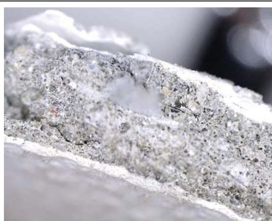
Zd.nr 50.Przekrój przez tynk cienkowarstwowo gr. 5,50 mm z wierzchnią warstwą wyprawy tynkarskiej od dołu zdjęcia.
