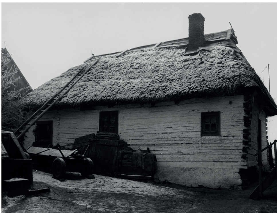
Ryc. 1. Radkowiec nr 86, gm. Chęciny. Dom z 1881 r. Elewacja północna. Stan w 1975 r. Fot. S. Stępień, XII 1975 r.
