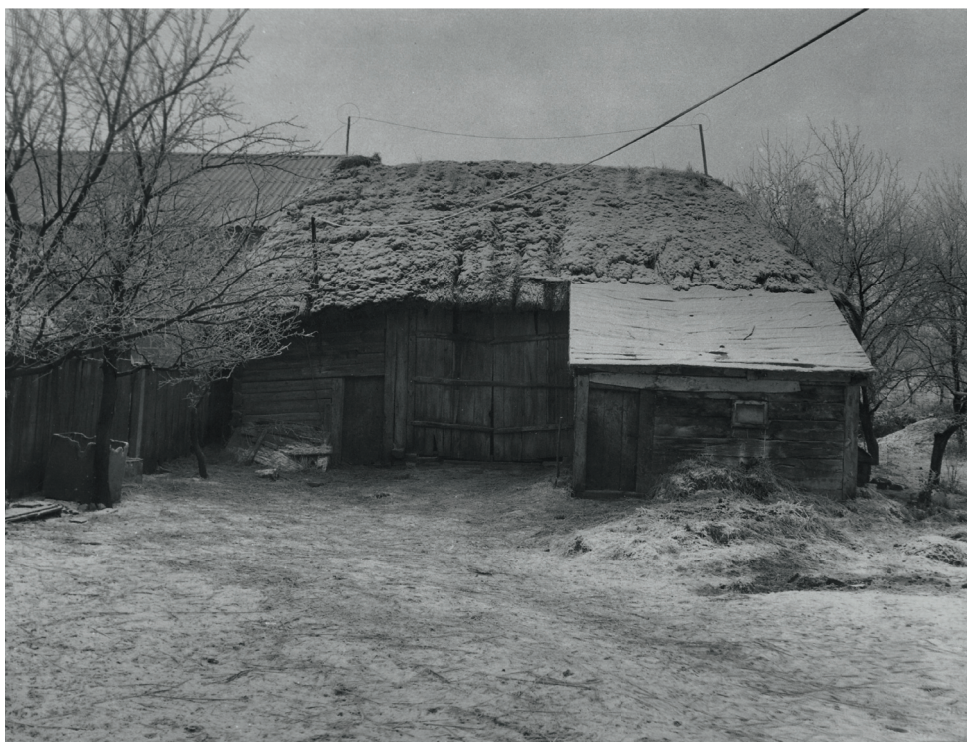
Ryc. 10. Radkowiec nr 14, gm. Chęciny. Obora ze stodołą z ok. 1880 r. Elewacja północna. Stan w 1975 r. Fot. S. Stępień, XII 1975 r.
