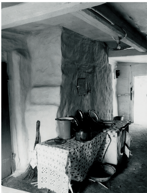
Ryc.5. Radkowice nr 21, gm. Chęciny. Dom z 1879 r. Urządzenia ogniowe w sieni. Stan w 1975 r. Fot. S. Stępień, XII 1975 r.
