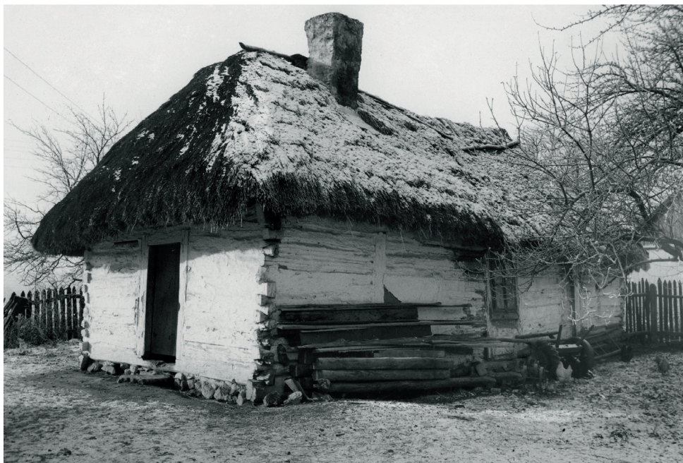
Ryc. 12. Radkowie nr 70, gm. Chęciny. Dom z 1876 r. Elewacja płn.-wsch. Stan w 1975 r.
