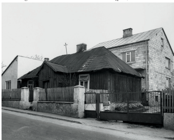
Ryc. 6. Radkowice nr 21, gm. Chęciny. Dom z 1879 r. Urządzenia ogniowe w izbie. Stan w 1975 r. Fot. S. Stępień, XII 1975 r.
