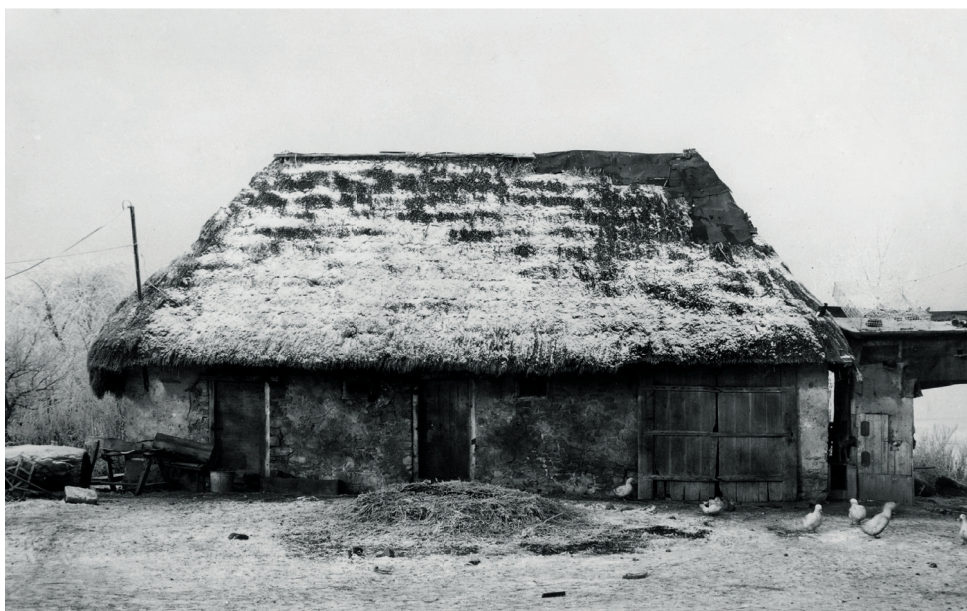
Ryc. 9. Radkowice nr 16, gm. Chęciny. Obora ze stajnią i wozownią z ok. 1875 r. Elewacja frontowa. Stan w 1975 r. Fot. S. Stępień, XII 1975 r.
