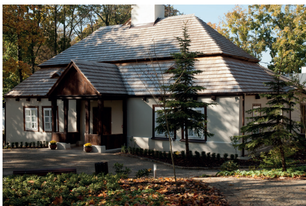
Ryc. 3. Dworek Laszczyków po remoncie.
