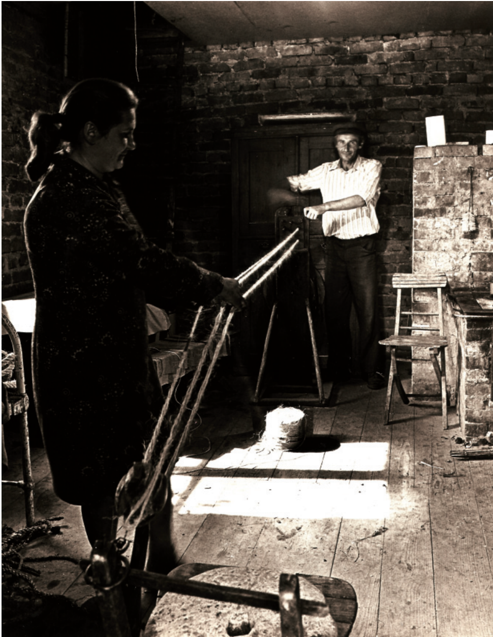
Ryc. 7. Końcowa faza kręcenia powroza złożonego z trzech „pokretek”. Na zdjęciu widoczna drewniana „babka” powroźnicza. Fot. J. Mąkowski.
